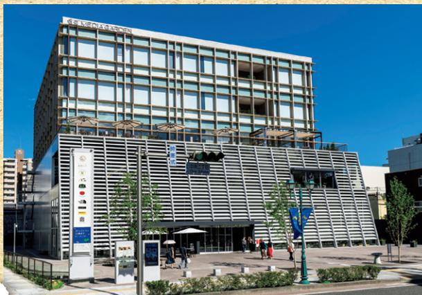
松本の豊富な地下水、隣接小河川を空調の熱源にし、外気取り入れや床層射冷暖房によって省エネルギー化を図ったビル
